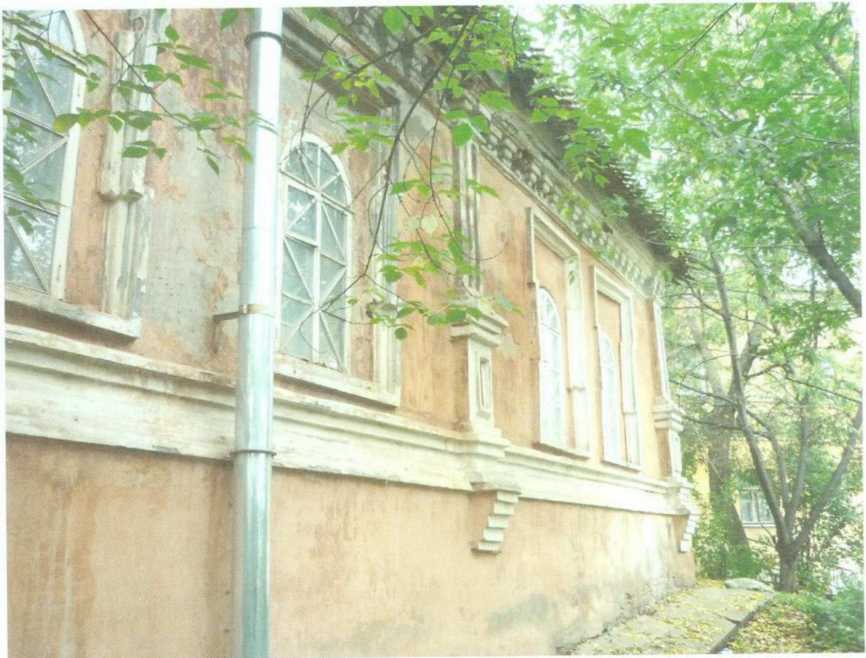
Фото 5. «Приказная изба, начало XVIII в.», г. Киров, ул. Спасская, д. 46. Вид на юго-восточный фасад. Фото Брызгалов Ю.П. Дата – 10.09.2015.
