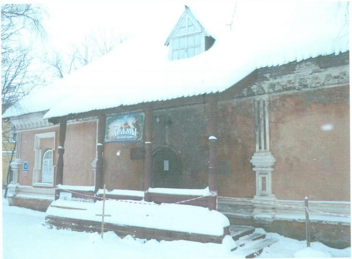
Фото 2. «Приказная изба, начало XVIII в.», г. Киров, ул. Спасская, д. 46. Вид на северо-западный фасад. Фото Брызгалов Ю.П. Дата – 14.01.2016.
