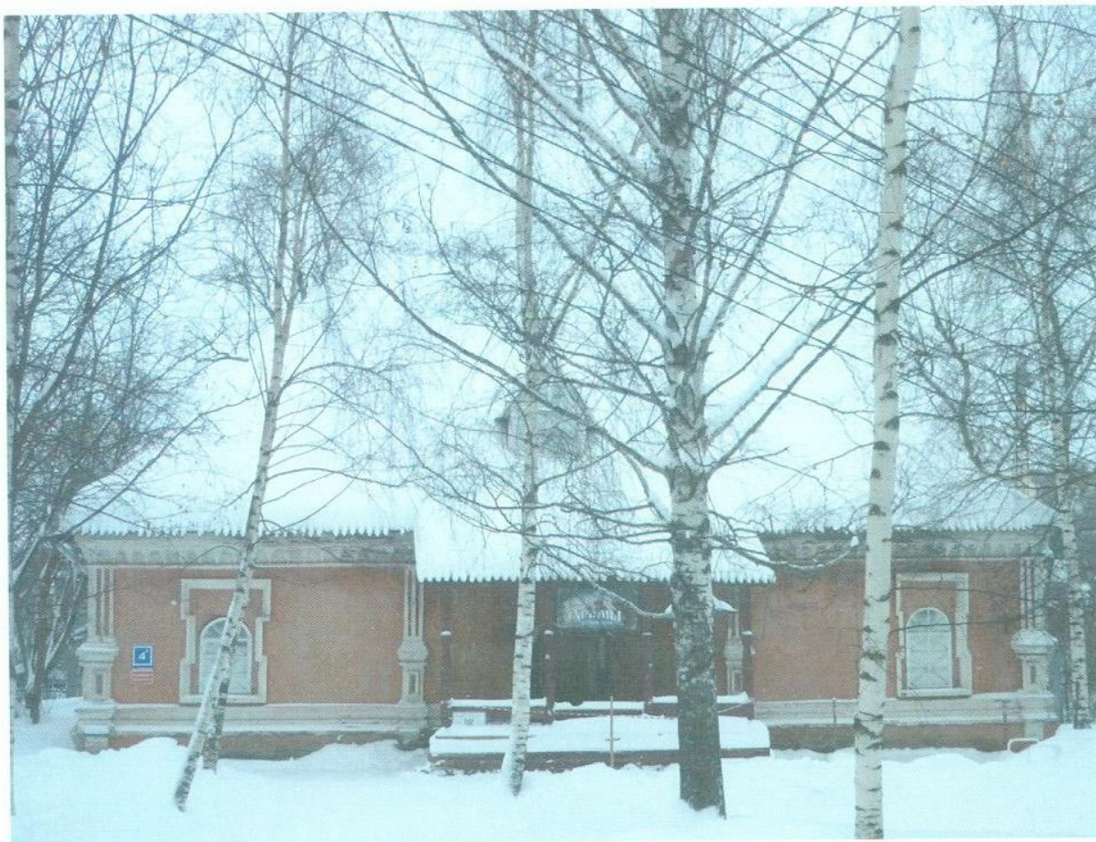
Фото 1. «Приказная изба, начало XVIII в.», г. Киров, ул. Спасская, д. 46. Вид на северо-западный фасад. Фото Брызгалов Ю.П. Дата – 14.01.2016.
