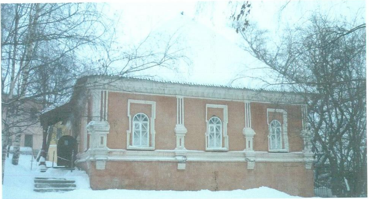
Фото 4. «Приказная изба, начало XVIII в.», г. Киров, ул. Спасская, д. 46. Вид на юго-западный фасад. Фото Брызгалов Ю.П. Дата – 14.01.2016.
